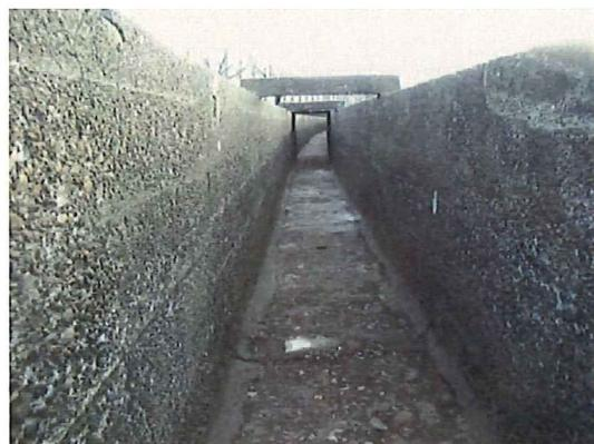
摩耗が著しく、目地や亀裂からの漏水が見られ通水に支障がでている水路
