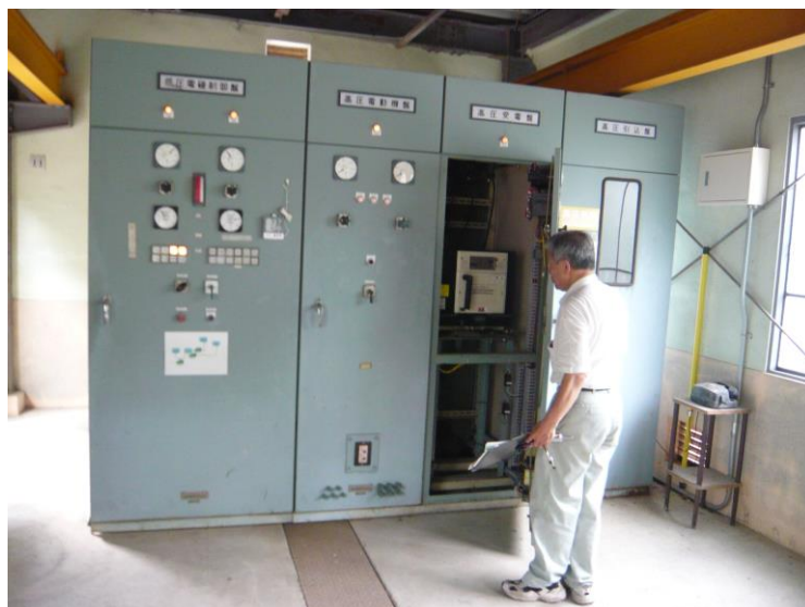
土地改良施設の点検
