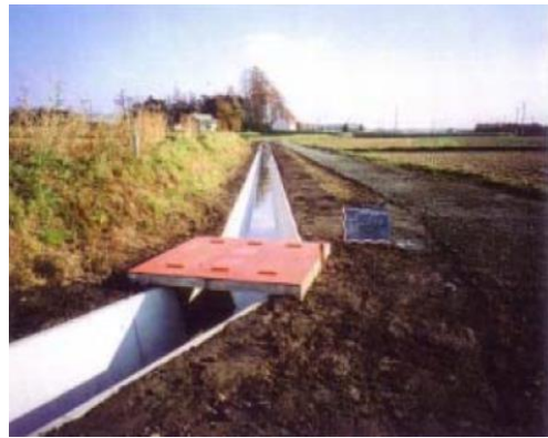
漏水により通水能力が落ちた水路の更新を行った
