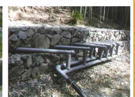
水抜きボーリング
