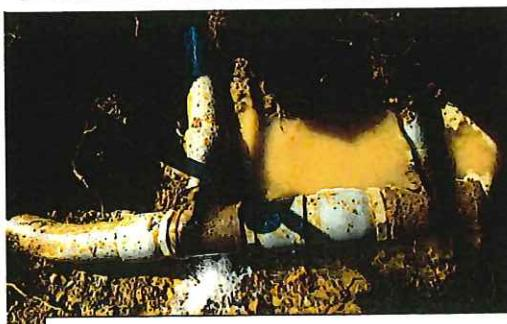
T-Sソケット破損：漏水事故
