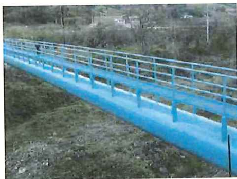
水管橋の補修・塗装
