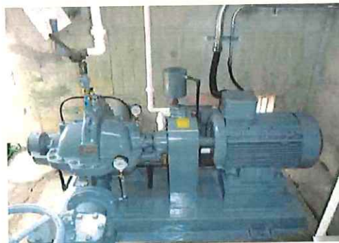
ポンプの補修・更新
