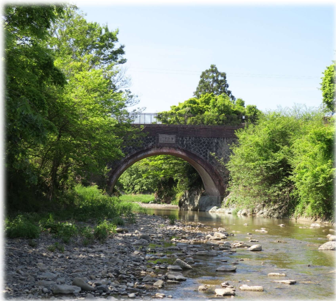
世界かんがい施設遺産 龍之渡井（小田井土地改良区）
