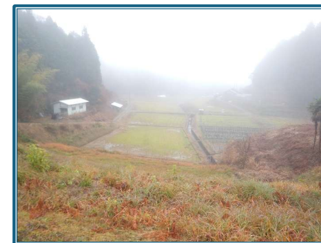
【ため池下流状況】
