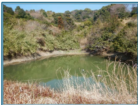
【ため池貯水状況】
